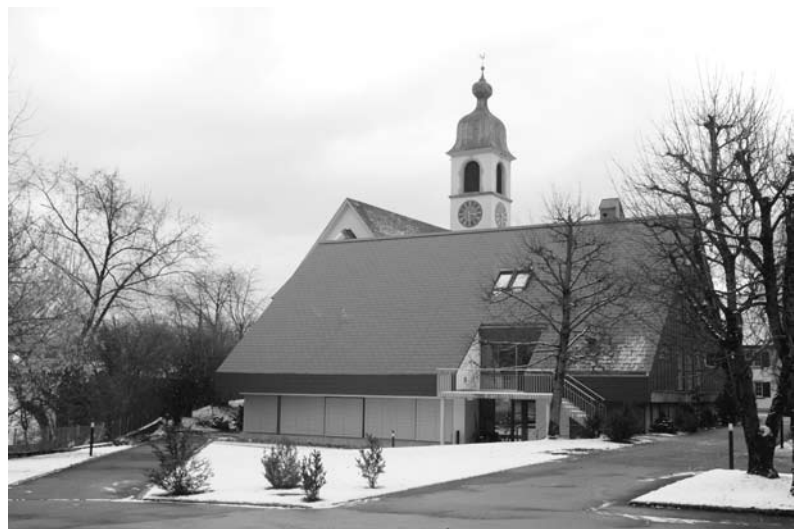
Ostseite des Kirchgemeindehauses Rapperswil. Das Dach ist heute gut gedämmt und aus dem ersten Stock führt ein neuer Ausgang.
