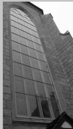
*St. Otmar, St. Gallen SG: Belüftete Aussenschutzverglasung (ca. 1950). Breite Lüftungsschlitze am unteren und oberen Rand sorgen für die Belüftung dieser nach aussen vorgehängten Schutzverglasung.*
