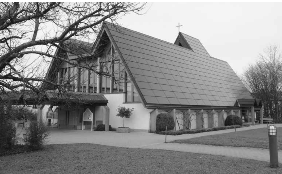
«Himmlischer Strom» in der Stadt St. Gallen: Die ökumenische Haldenkirche hat den Solarpreis 2012 gewonnen. Die 225 m 2 grosse, ganzflächige Solaranlage ist optimal integriert. Sie liefert rund 49 000 kWh Solarstrom, was etwa dem Jahresverbrauch von 14 Haushalten entspricht. Foto: Claudia Baumberger
