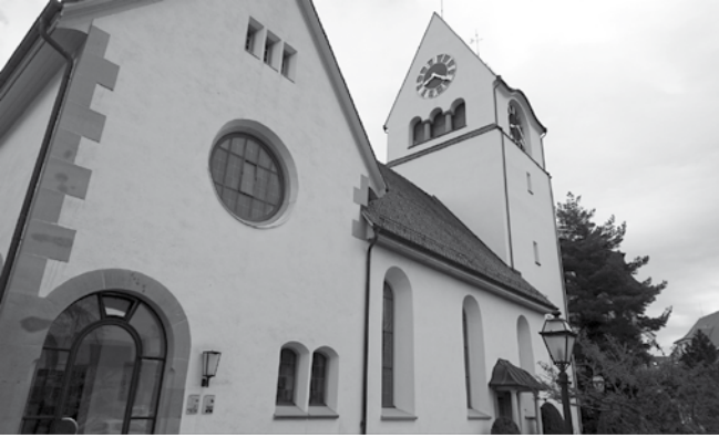
Die reformierte Kirche in Fehraltorf wurde 2017 mit einer programmierbaren Heizungssteuerung ausgerüstet. Bild: Mischa Gebert, AVM Solutions AG
