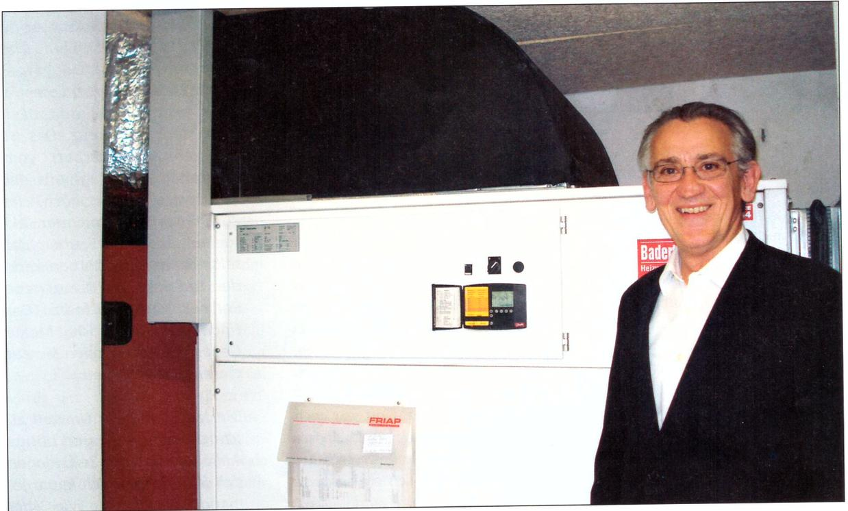
Mit der neuen Wärmepumpe und der Kellerisolation konnten im Bischöflichen Haus 60 Prozent der Heizkosten eingespart werden.
