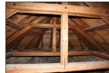
Abb. 4: Kompakte Bretterschalung als Unterdach (alle Fotos: E. Mühlethaler)
